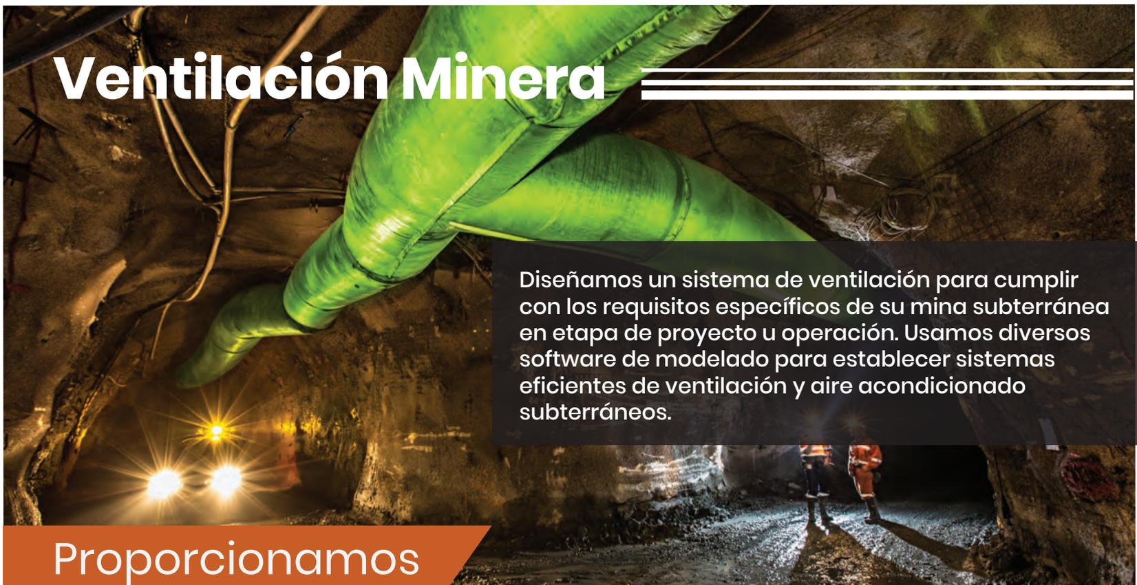
Diseñamos un sistema de ventilación para cumplir con los requisitos específicos de su mina subterránea en etapa de proyecto u operación. Usamos diversos software de modelado para establecer sistemas eficientes de ventilación y aire acondicionado subterráneos.
